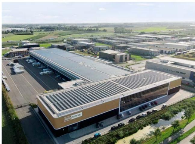
Abb.: SAB-Paneelwerk in Geldermalsen mit rund 5.000 PV-Elementen
