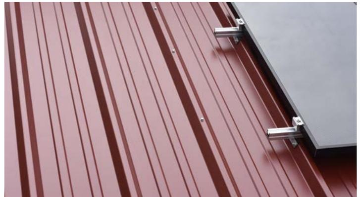
Bei Installation einer Solaranlage wird die Beschichtung in Bezug auf Abrieb- und Kratzfestigkeit noch weiter beansprucht. Unsachgemäße Handhabung von Materialien und Werkzeugen kann hier, bei zu geringer Beschichtung, zu Kratzern führen und somit das Dach nachhaltig korrosiv schädigen.
