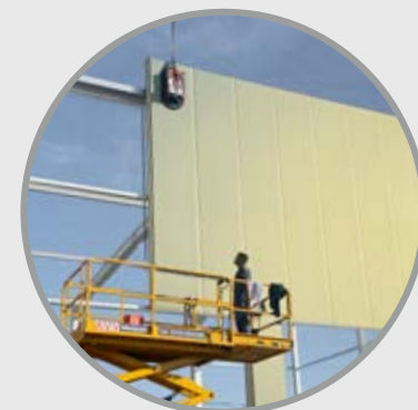
Verlegung von Sandwich-Paneelen mit einem Vakuum- Hebegerät
