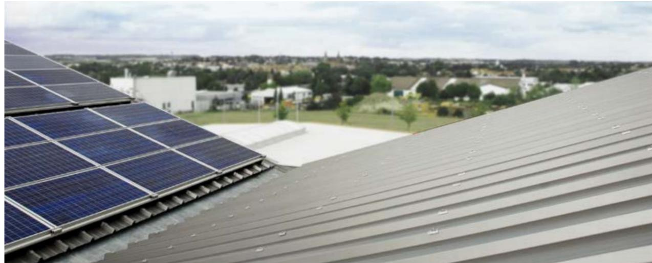
Die Abdeckung der eigentlichen Dachfläche durch die PV-Module verhindert die üblichen Reinigungseffekte durch Regen und Wind. So können sich schon nach kurzer Zeit Laub, Astwerk und andere Verschmutzungen unter den Solarpaneelen sammeln und zu einer erhöhten korrosiven Belastung führen.
